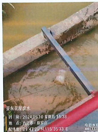
照片 26: 花屋矿区废水
