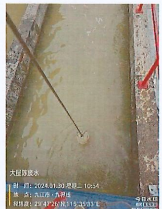
照片 32: 大屋陈矿区废水
