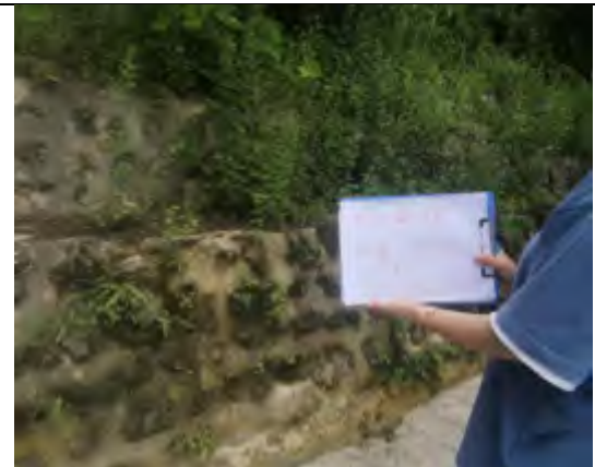
矿区道路侧排水及挡护（半山）
