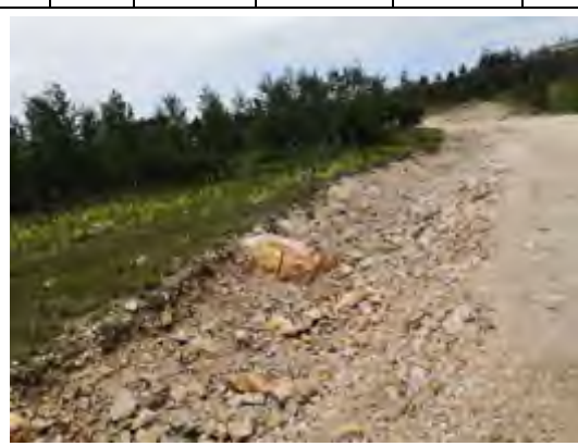
矿区开采区开挖的临时截排水沟
