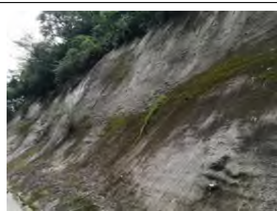
道路侧锚杆喷混护坡
