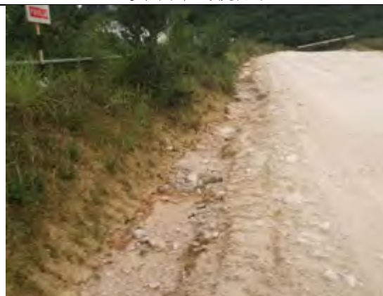
进矿道路侧排水沟
