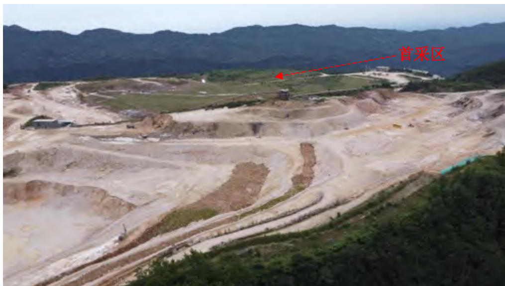
图 1-5 矿山建设情况一览图（一期工程建设期首采区平台已复垦）
