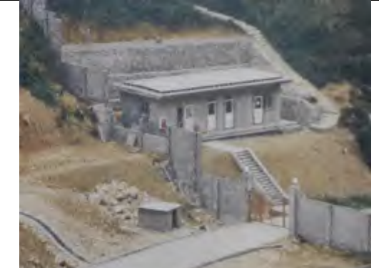
炸药库建设时临时排水沟
