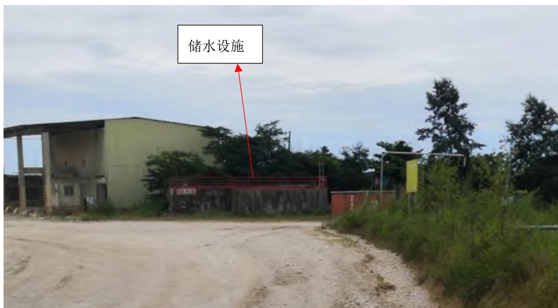
图 1-6 矿山储水设施
