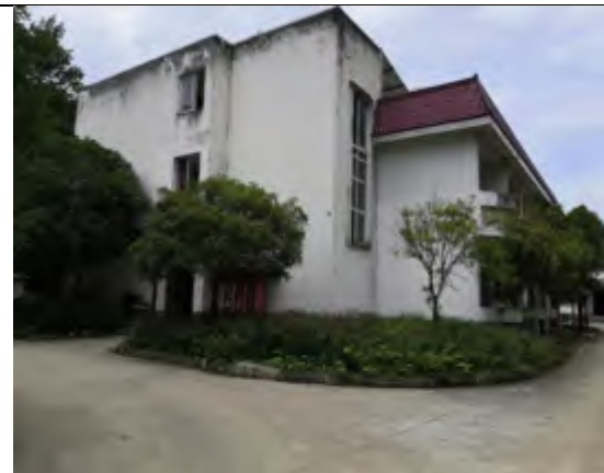
山下生活区建筑及绿化
