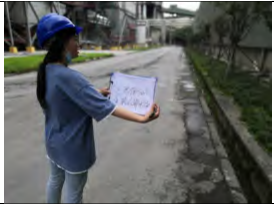
厂区西南侧道路及排水沟
