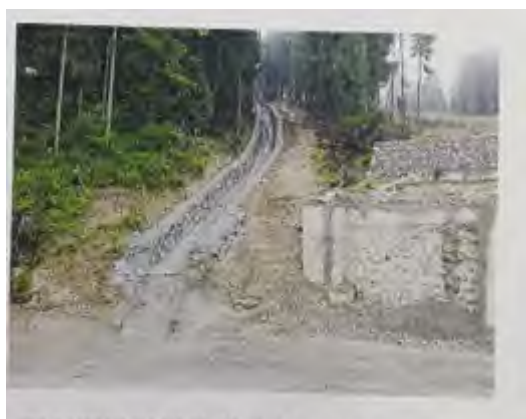
石灰石进矿道路排水沟（灾后重建）
