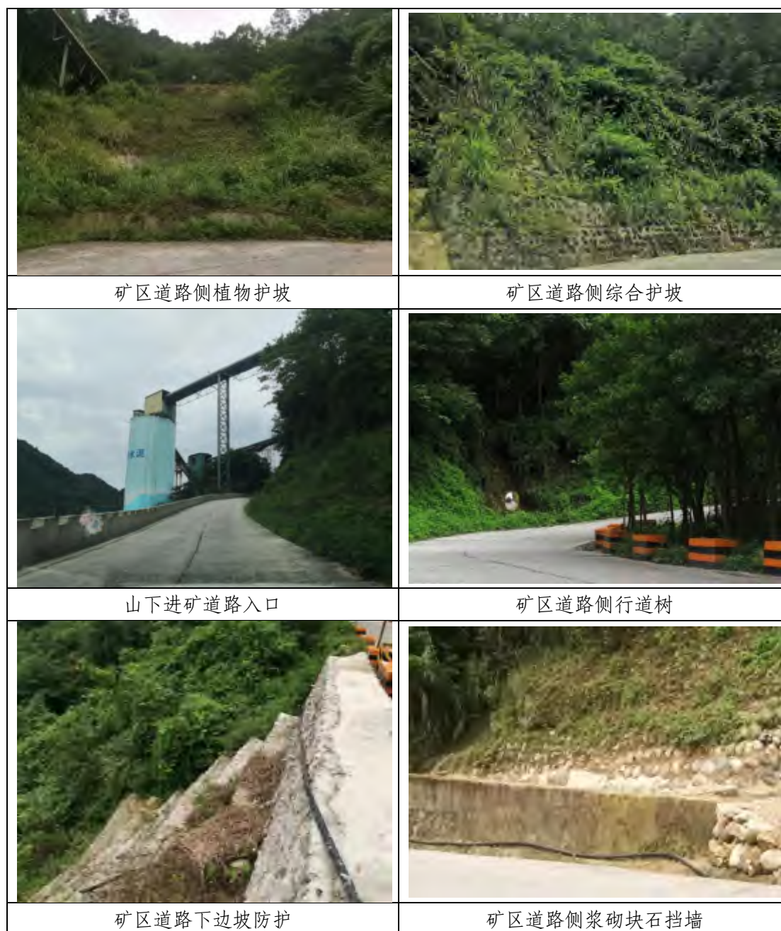
图 3-6 矿区道路水保措施完成情况照片
