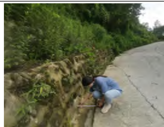
矿区道路排水沟监测
