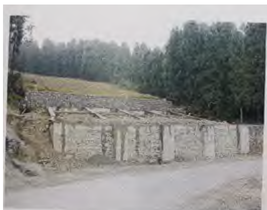
石灰石进矿道路挡墙（灾后重建）
