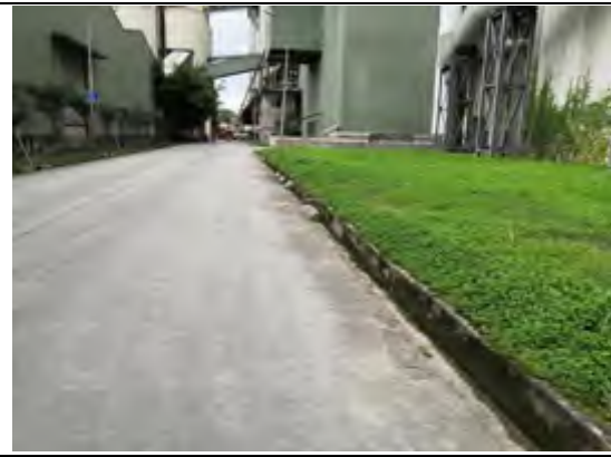
厂区一期生产线西侧排水沟
