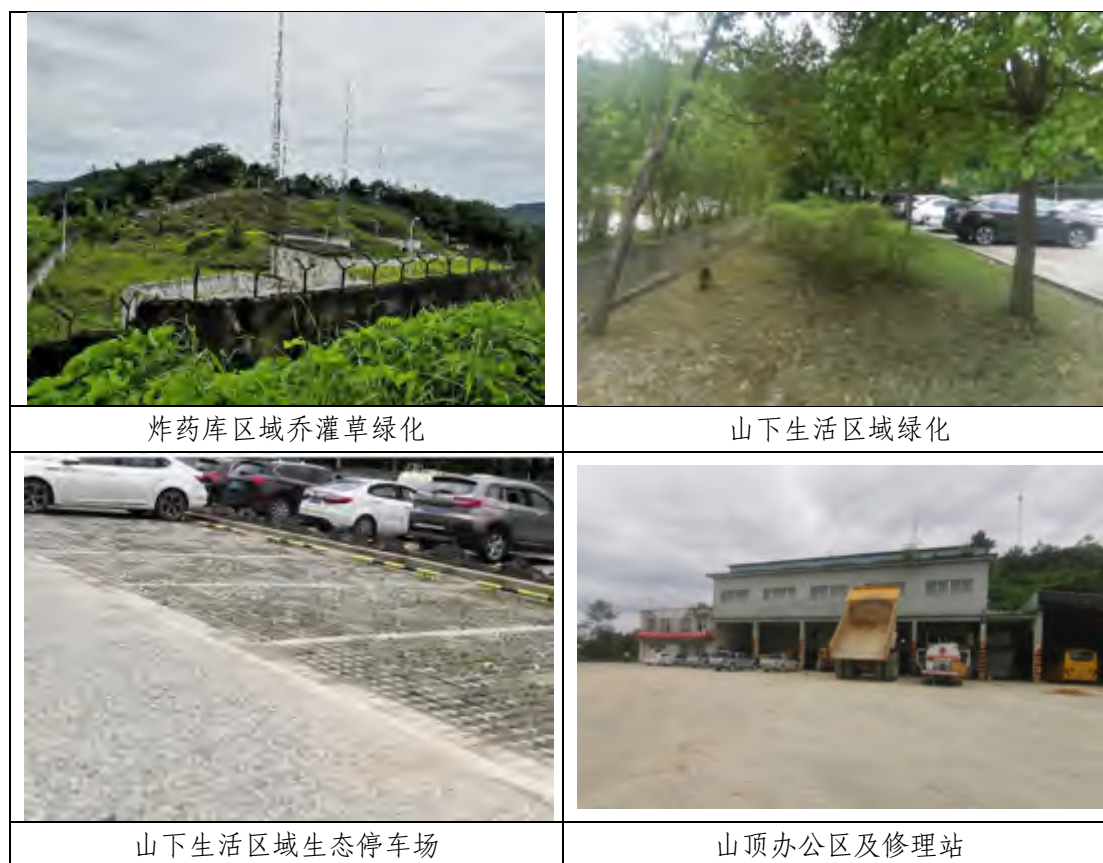
图 3-9 储料场及辅助生产生活设施占地区水保措施完成情况照片 (5) 矿山开采影响区
