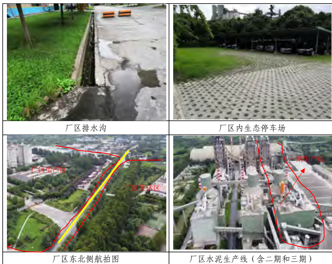
图 3-5 厂区占地水土保持措施完成情况照片
