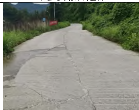
矿山道路硬化现状
