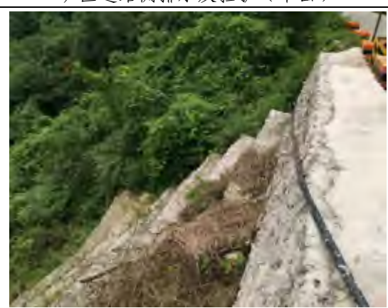
道路侧下边坡防护
