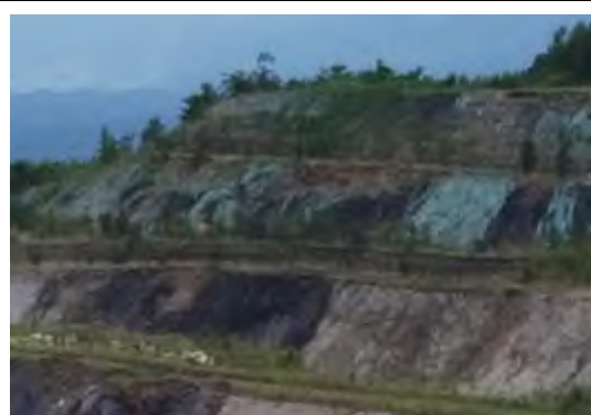
最终边坡密目网覆盖
