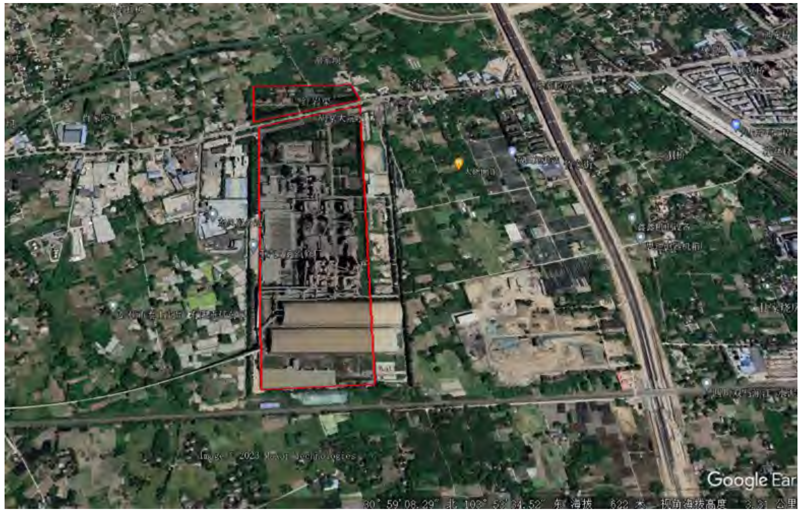
图 3-1 (3) 项目厂区建设完成后卫星影像图 (2022.11.28)
