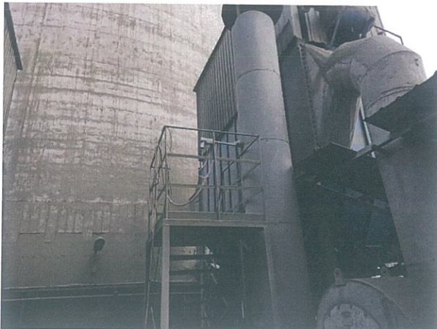
熟料库底南排放口（DA035）
