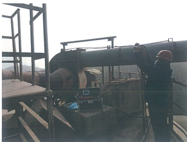
生料均化库顶排放口（DA004）
