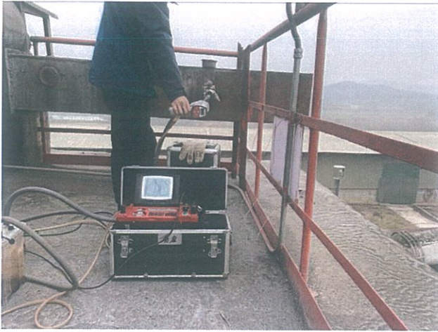
煤粉仓排放口（DA007）
