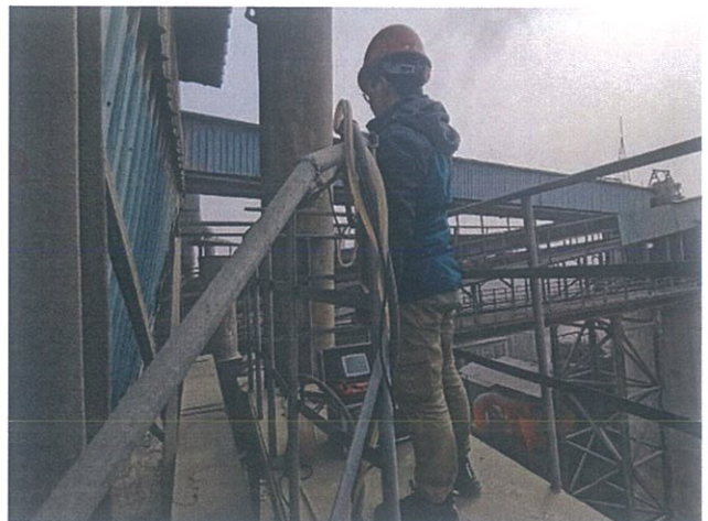
配粉 2#库顶废气排放口 (DA022)
