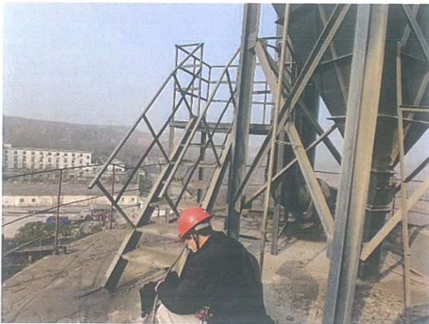
成品 8#库顶排放口（DA013）
