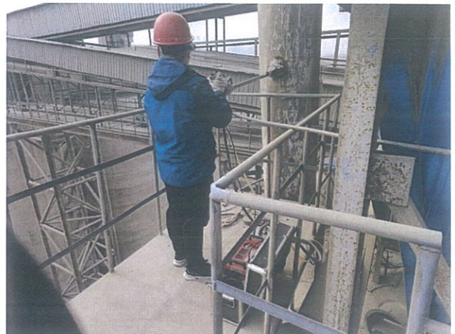
配粉 1#库顶废气排放口 (DA020)
