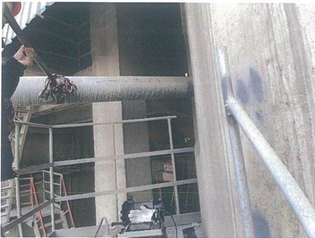
配粉 4#库底废气排放口（DA027）
