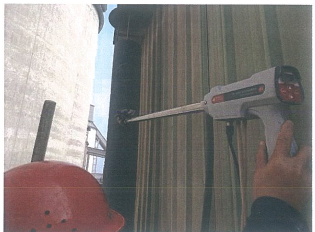
散泥 3#平台废气排放口（DA016）
