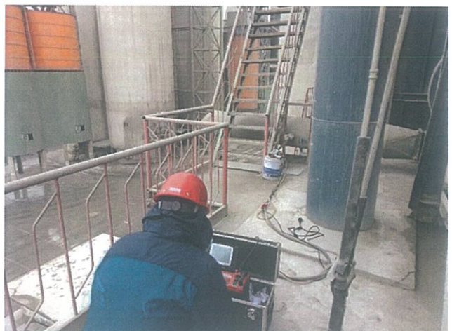
2#包装提升机排放口（DA018）
