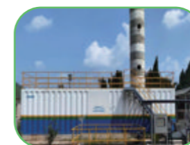
生活污水处理器
